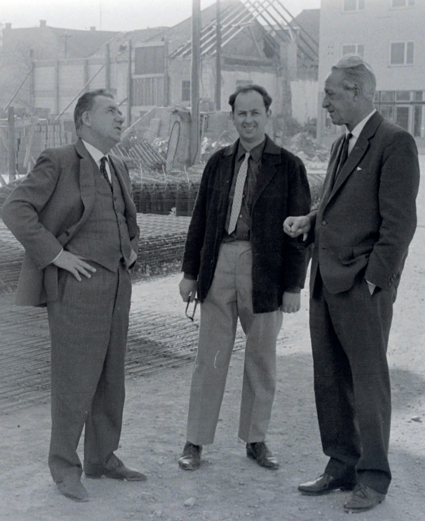
Architekt Rudolf Hutter (1.v.r.) mit seinem Mitarbeiter Ing. Erwin Zisser (Mitte) im Gespräch mit Bürgermeister und Baumeister Rudolf Strodl (1.v.l.) auf der Baustelle Hochhaus Mattersburg, ca. 1965, © Ing. Werner Prünner, Mattersburg
